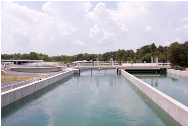
この水処理プラントでは、離れて設置されているコントローラとドライブをつなぐため、リング状の光ファイバーにて Profinet を使っている
